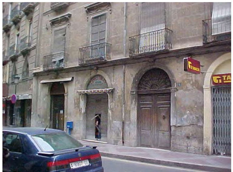
2. Vista de los bajos en fachada.
